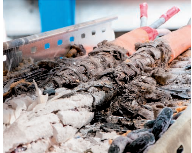
...y tras el ensayo contra incendio
