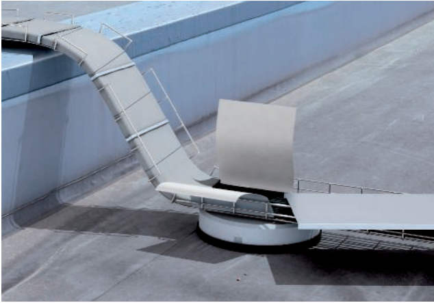
Cables envueltos guiados a través del muro cortafuegos
